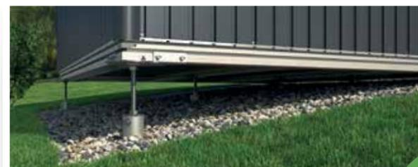
Mit dem Standard-Erdschrauben können Bodenunebenheiten und Hangneigungen bis zu 10% Gefälle ausgeglichen werden. Für größere Höhenunterschiede sind Verlängerungen auf Anfrage erhältlich.
