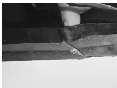
15. Den Lichtschacht mit den beiden oberen Schrauben an der Wand fixieren. Dann die restlichen Schrauben einsetzen. Die Schrauben mit Drehbewegungen durch die Dichtmasse arbeiten. Die Schrauben nach und nach handfest anziehen. Nach ca. 1 Stunde die Schrauben nachziehen. Dabei Dichtfix bis auf ca. 5-7mm Stärke zusammendrücken
