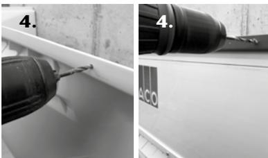
4. Mit 4 mm Bohrer Rostkante des Lichtschachtes und oder des fixen Aufstockelementes durchbohren. Seitlich ca. 50 mm von Wand entfernt bleiben. Die Bohrungen in gleichmäßigen Abständen setzen.
