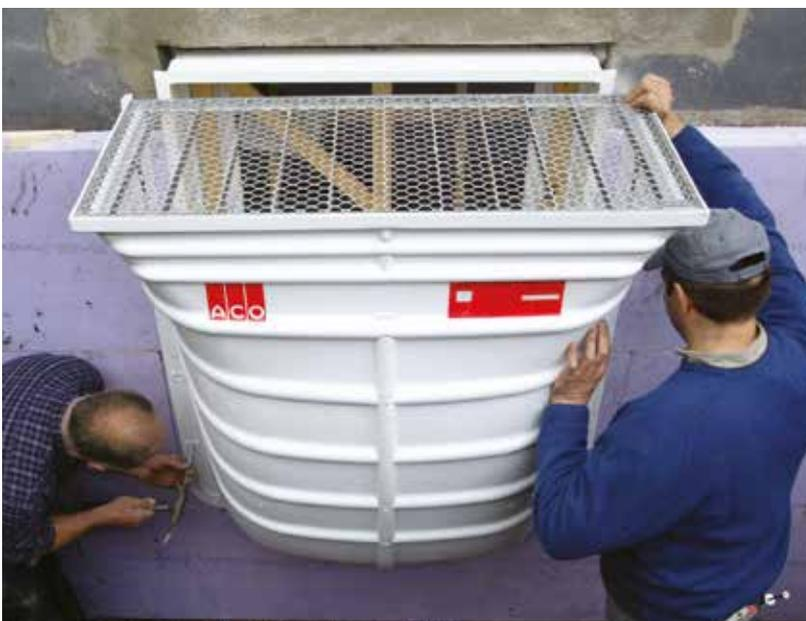
ACO Lichtschacht aus Polypropylen (PP) mit Aussteifungsrippen
