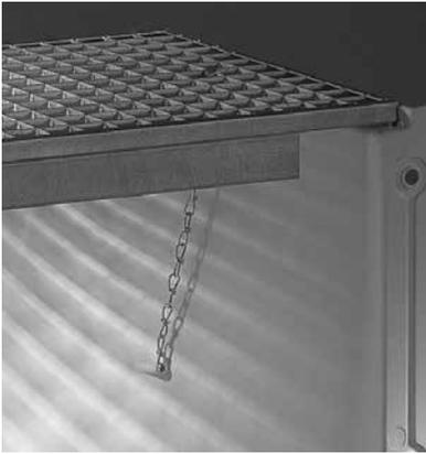
1. Lichtschacht vor der Montage auf Beschädigungen überprüfen. Lichtschächte mit Rissen, Abplatzungen oder sonstigen Beschädigungen sind für eine DWD-Montage nicht geeignet.
