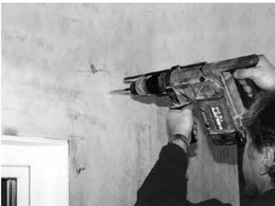
4. Bohren Sie alle zusätzlichen Befestigungspunkte am Lichtschacht auf.
