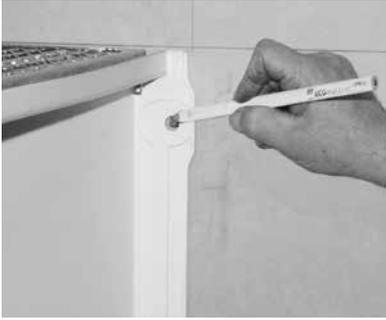
6. Den Lichtschacht provisorisch einhängen und handfest anschrauben, dann die restlichen Bohrlöcher anzeichnen. Jetzt den Lichtschacht wieder abnehmen und die Löcher mit Tiefenanschlag (7 cm) bohren. Die Bohrlöcher sind möglichst punktgenau und senkrecht zur Wand zu setzen. Bohrlöcher reinigen. Schwerlastdübel einschlagen. Die Wand mit Besen oder feuchtem Quast reinigen.
