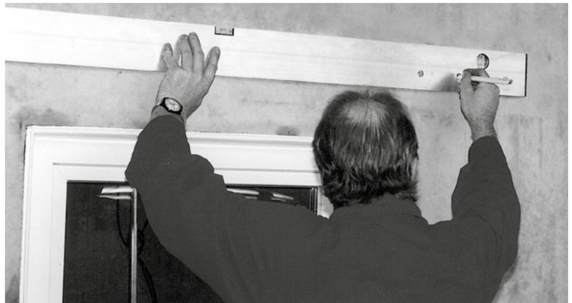
2. Die Lage des Lichtschachtes bestimmen (Oberkante Lichtschacht, Mitte Fenster) und mit der Montagehilfe für Lichtschächte die beiden obersten Löcher anzeichnen. (OK Montagehilfe = OK Lichtschächte) Den Lichtschacht anhalten und die Kontur grob mit dem Bleistift markieren.
