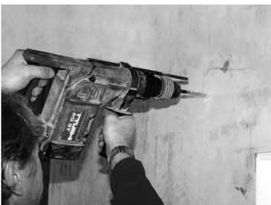
10. Jetzt den Lichtschacht wieder abnehmen und die Löcher mit Tiefenanschlag (7cm) bohren. Es sind alle Bohrlöcher zu verwenden! Bohrlöcher reinigen. Die Wand mit Besen oder feuchtem Quast reinigen. Restlichen Dübel mit Distanzhülse einsetzen.
