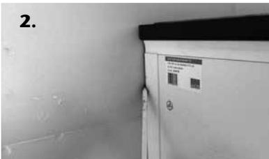
2. Außenkante des Wandanschlussprofils beidseitig auf Montageuntergrund anzeichnen. Aufstockelement vom Lichtschacht nehmen und Wandanschlussprofile vom Aufstockelement entfernen. Beim Einsatz von lediglich einem begehbaren fixen Aufstockelement kann auf die Wandverschraubung verzichtet werden.
