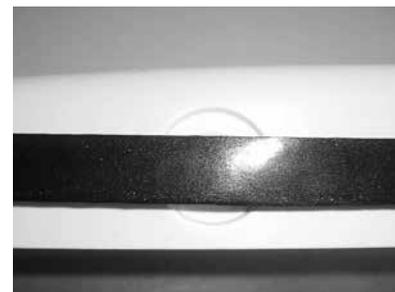
13. ACO Dichtfix mittig über die Kittrille und den Befestigungsbohrungen ansetzen und andrücken. Dabei insbesondere im Radienbereich des Lichtschachtes auf gute Haftung achten. Die Befestigungsbohrungen müssen vollständig überdeckt sein.
