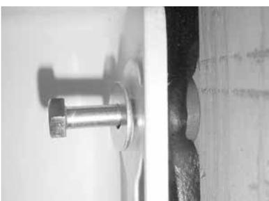
14. Die beiden oberen Schrauben mit Drehbewegungen durch die Dichtmasse arbeiten.
