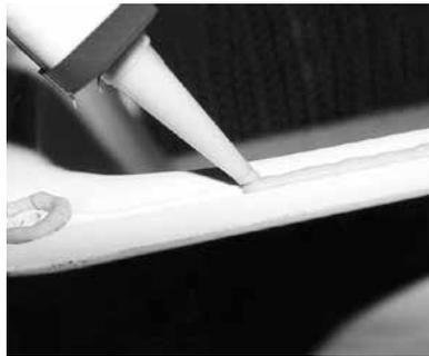
9. In die Kittrille im Lichtschachtflansch ACO Profix gleichmäßig dick aufbringen. Verbrauch ca. 1 1/2 Kartuschen. Die Ansatzstellen mit der Spitze verschmieren.
