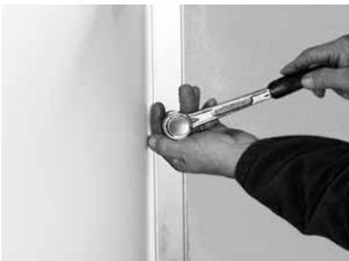
11. Die Bögen links und rechts aufsetzen und leicht anschrauben. Die untere kurze Schiene aufsetzen und leicht anschrauben. Dann alle Schrauben gleichmäßig fest anziehen, sodass das ACO Profix an
