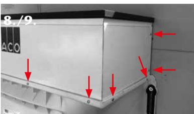
8. Aufstockelement mit Lichtschacht verschrauben. Mit 4 mm Bohrer vorbohren. Hierzu Spaxschrauben mit Spitze verwenden. Vorderseitig 4 Schrauben (Großlichtschacht 6) und seitlich je 2 Schrauben (Großlichtschacht 3) eindrehen.
