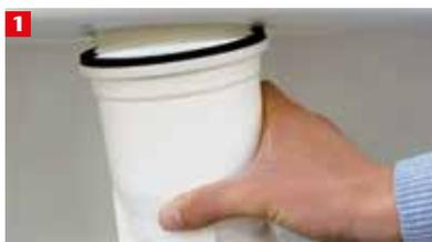
Den Einschraubring von oben durch die Lichtschacht-Entwässerungsöffnung führen. Den Grundkörper von unten auf den Einschraubring schrauben.
