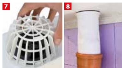
Den Laubfangkorb aufstecken und arretieren. Den ACO Lichtschacht an die Kellerwand montieren. Der Abstand von Fensterunterkante bis zum Lichtschachtboden muss mind. 15 cm betragen. KG-Rohr DN 100 muffenseitig anschließen
