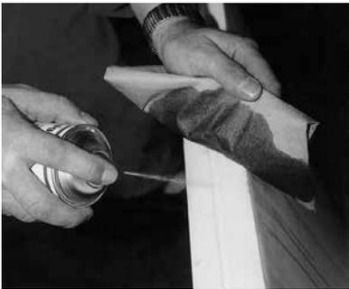
8. Den Lichtschachtflansch gut reinigen, z.B. mit Aceton.
