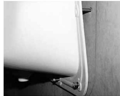
10. Den Lichtschacht gleichmäßig auf die senkrechten Bolzenreihen aufsetzen. Links und rechts die beiden langen Schienen aufsetzen und leicht anschrauben.
