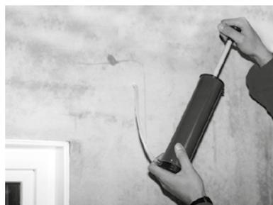
4. Bohrlöcher reinigen.
