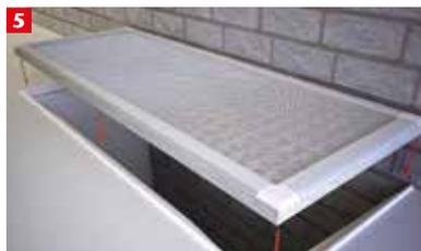
5 Befestigen Sie die Abdeckung am Gitterrost. Zum Abschluss montieren Sie den Rost wie im Ursprungszustand an Ihrem Kellerschart.
