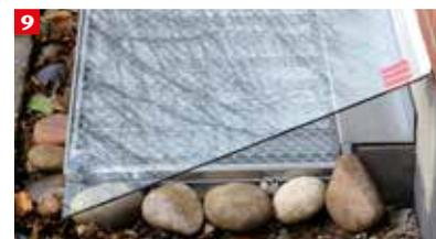
Während der Rückstauphase kann die Entwässerung von anfallendem Oberflächenwasser nicht erfolgen. Aus diesem Grund empfehlen wir den Einsatz der ACO Lichtschachtabdeckung. Wichtig für die Außen-gestaltung: Der angrenzende Oberflächenbelag am Lichtschacht muss so ausgebildet werden, dass kein Oberflächenwasser in den Lichtschacht laufen kann.
