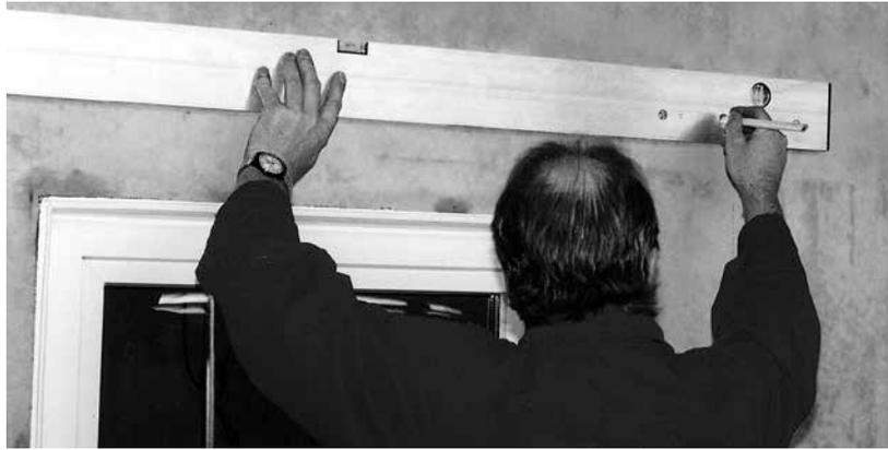
3. Die Lage des Lichtschachtes bestimmen (Oberkante Lichtschacht, Mitte Fenster) und mit der Montagehilfe für Lichtschächte die beiden obersten Löcher anzeichnen. (OK Montagehilfe = OK Lichtschacht) Den Lichtschacht anhalten und die Kontur grob mit dem Bleistift markieren.
