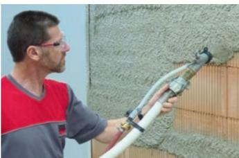
Putz maschinell raupenförmig aufspritzen
